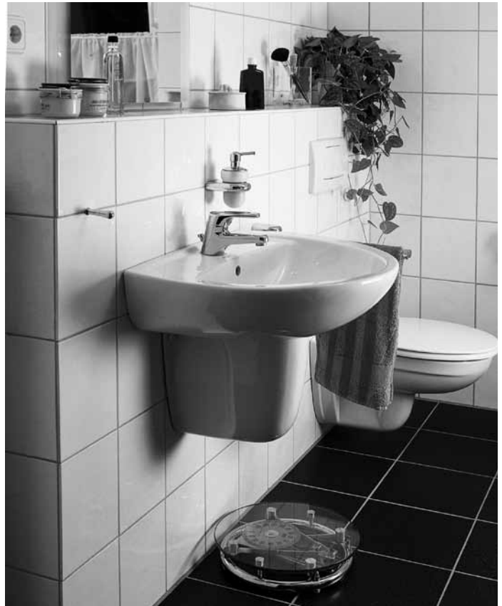
Завершенная перегородка с санфаянсом
